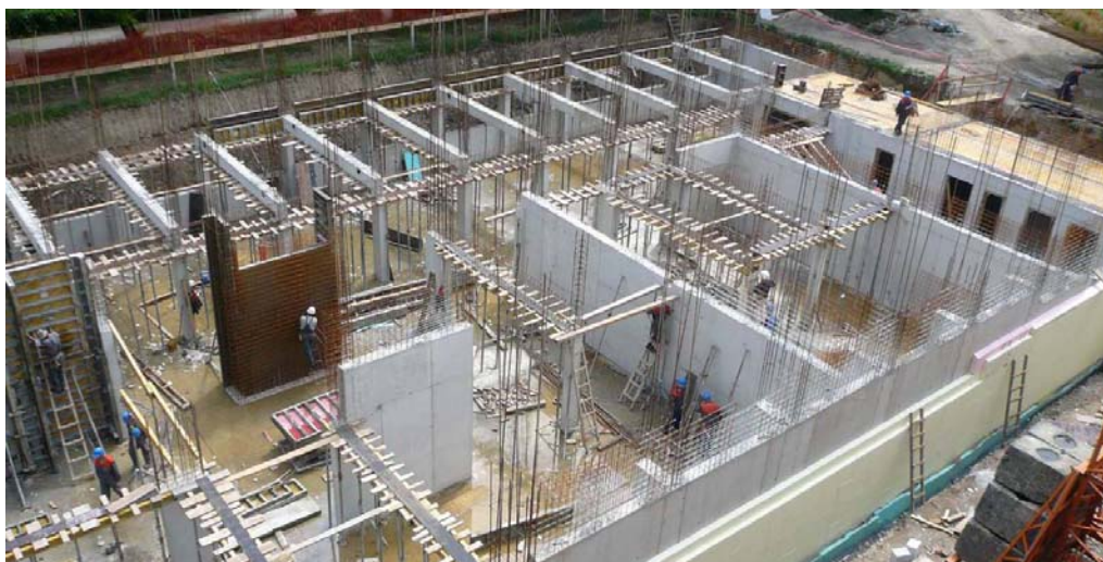
Слика 12. Армиранобетонска конструкција подземне етаже
