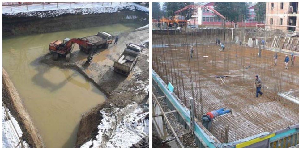
Слика 10. Темељна јама дограђеног дијела објекта
