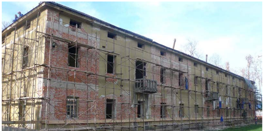
Слика 6. Конструкција објекта након уклањања фасаде
