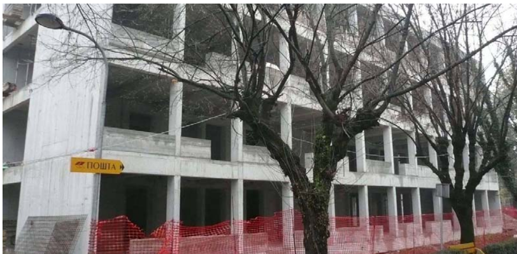
Слика 13. Источна фасада новог дијела објекта
